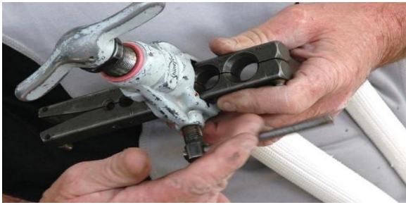
Figure 35: Flare the end of the tube (D)
