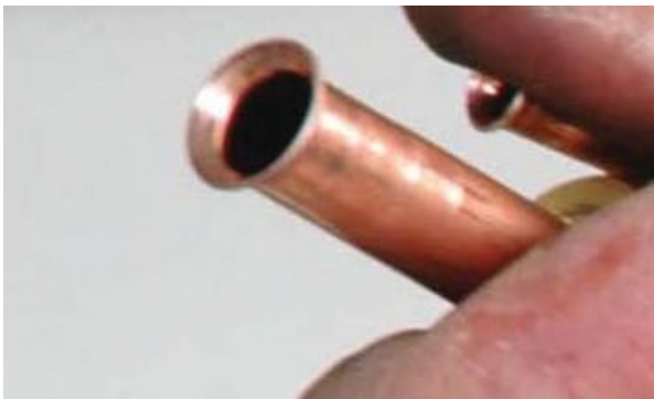
Figure 35: Flare the end of the tube (D)
